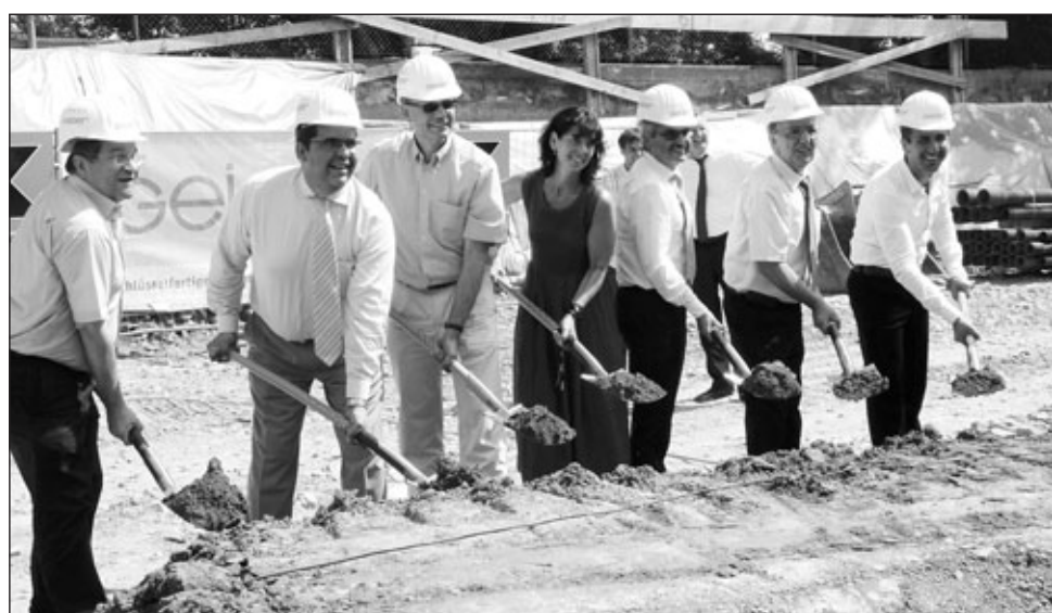
Der erste Akt auf dem früheren Seitz-Gelände ist begangen – auch Baubürgermeisterin Priebe packte tatkräftig zur Schaufel, um den ersten „Spatenstich“ auf dem alten Seitz-Areal zu unternehmen. Foto: Peters
