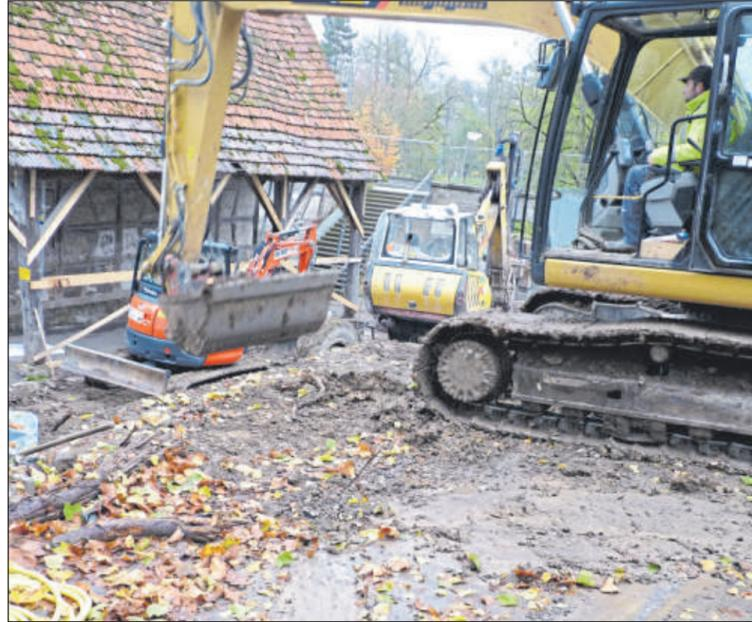
Große und kleine Bagger sind bei den Abgrabungen im Einsatz: dieser greift vom Zellerplatz nach unten, um das abgeschabte Material oben zum Transport abzulegen. Unsere Bilder zeigen die Bauarbeiten am Montag, 6. November 2017. Fotos: Redmann
