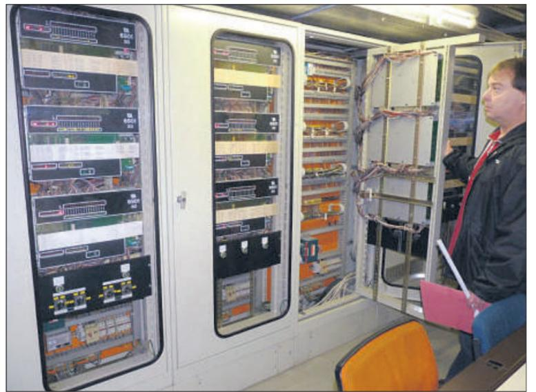
Die Regeltechnik für die Lüftung und die Heizung des Bürgerzentrums soll in der Sommerpause 2012/2013 ausgetauscht werden. Auch zwei der fünf Aufzüge werden mit neuen Betriebssystemen versehen. Unser Bild zeigt Elektromeister Sieghart Wahlenmaier im UG. Foto: Redmann
