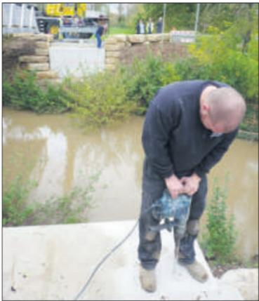
Parallel-Bohren: auf jeder Fundamentseite waren zweimal vier Löcher zu bohren, in die anschließend die 220er-Dübel passen sollten.
