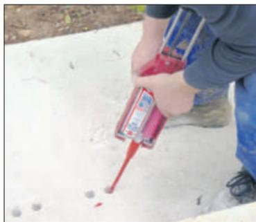
Kaum zu glauben: eine Brücke mit 3,7 Tonnen Gewicht wird durch in Spezialklebstoff gebettete Dübel fixiert.
