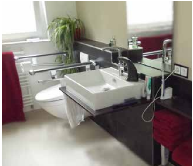
Bad-WC-Dusche nach DIN 18040/2 Sanierung im Jahr 2014
