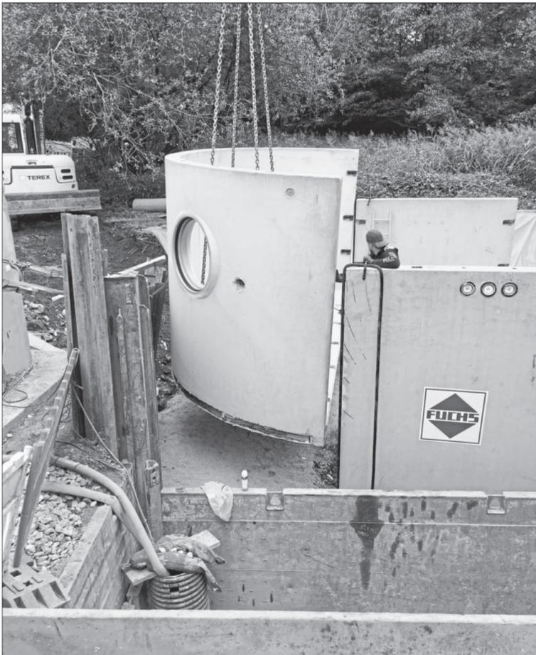
Das Regenüberlaufbecken in der Beinsteiner Straße besteht aus vorgefertigten Einzelmodulen, die vor Ort dicht miteinander verbunden werden. Am Montag, 1. Oktober 2018, sind sie „versetzt“ worden. Foto: Eigenbetrieb Stadtentwässerung
