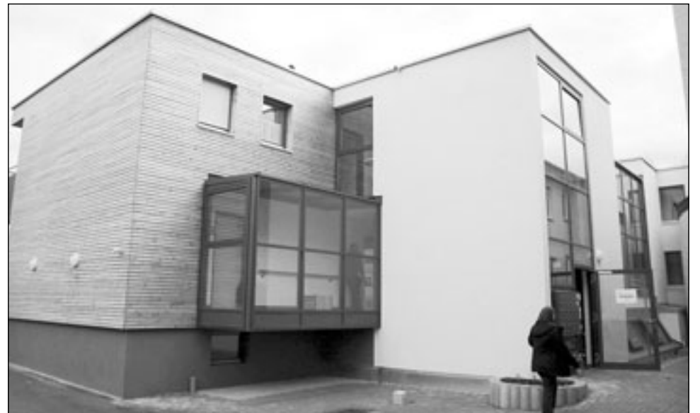
Früher war das „Haus an der Rems“ in Beinstein ein Bauarbeiter-Wohnheim; es wurde aufwändig und ökologischen Gesichtspunkten entsprechend renoviert. Fotos: David
