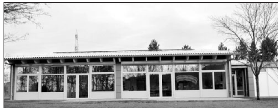
Auf dem Dach des Lindenschul-Hortes wurde die neue Anlage jüngst kaum sichtbar installiert.
