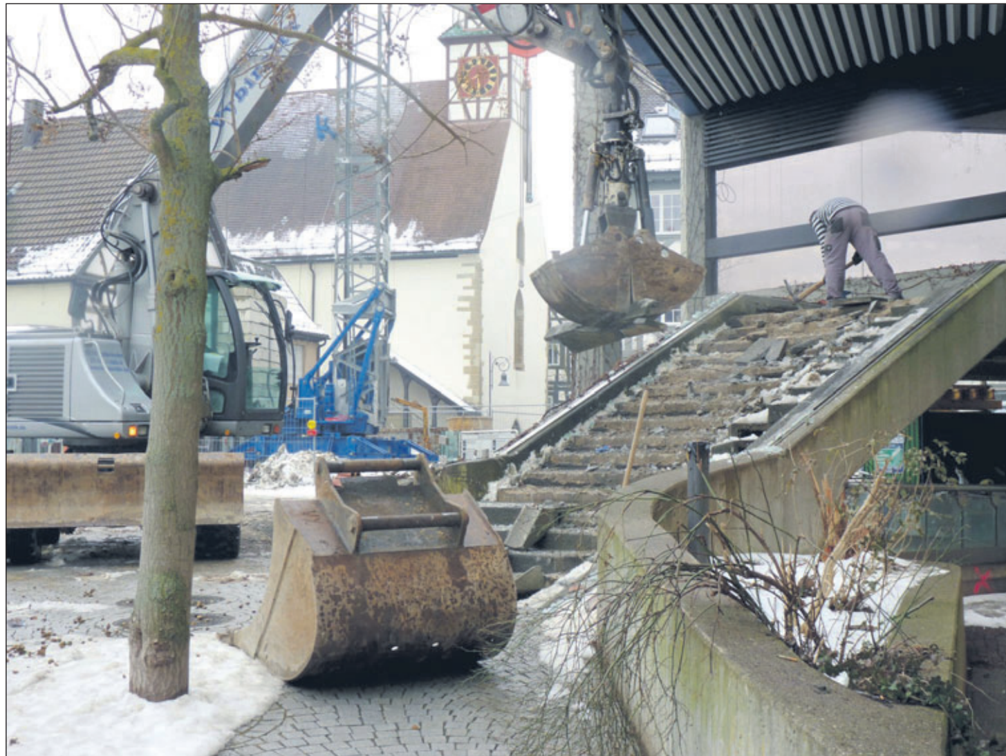
Mühsam wurden die Stufen der Treppe am ersten Abrisstag mit Hilfe des Baggers oder in Handarbeit herausgebrochen.
