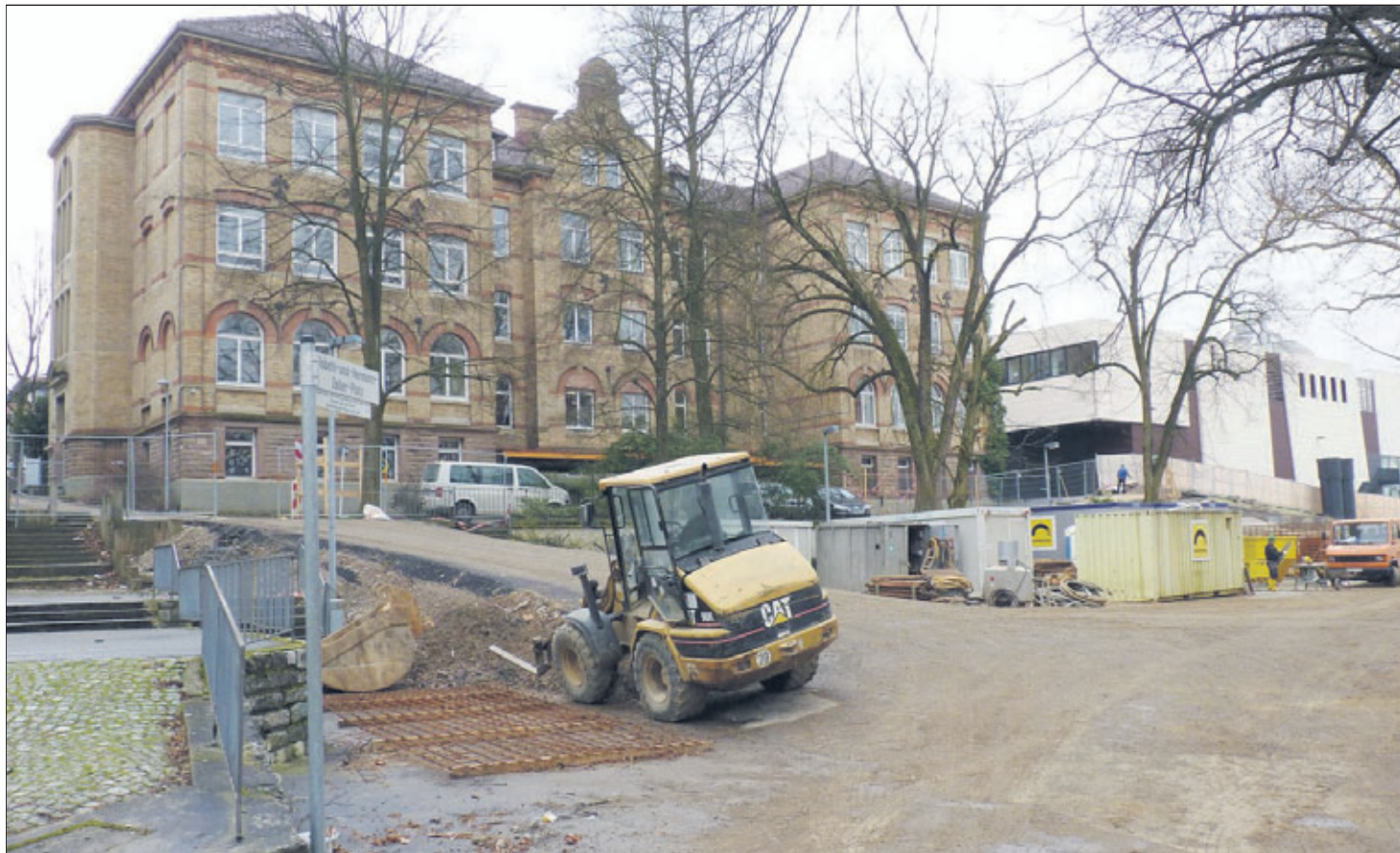
Der frühere untere Schulhof der Karolingerschule ist zwar derzeit mit Baustellenfahrzeugen für den zweiten Bauabschnitt des Postplatzes belegt. Dieser soll aber umgestaltet werden. Der Anfang soll mit einer Reitertreppe im Rücken des neuen Gebäudes gemacht werden. Foto: David
