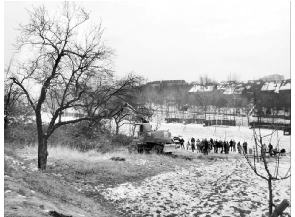
Hier, oberhalb der Winender Straße, werden die acht Passivhäuser der Wohnwert Projektbau GmbH entstehen. Die Stadt Waiblingen, die die Bauplätze an den Bauträger verkauft hatte, zeichnete das Unternehmen für diese Absicht, energieeffizient zu bauen, im Rahmen des „European Energy Award“ aus.
