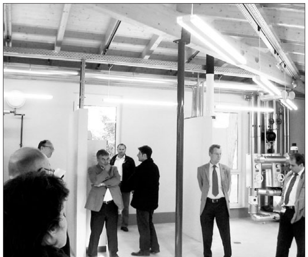
Beim ersten „Waiblinger Energieforum Wirtschaft“ haben die Teilnehmer aus Waiblinger Unternehmen auch die hochmoderne Heizzentrale der Stadtwerke besichtigt. Foto: Läßle
