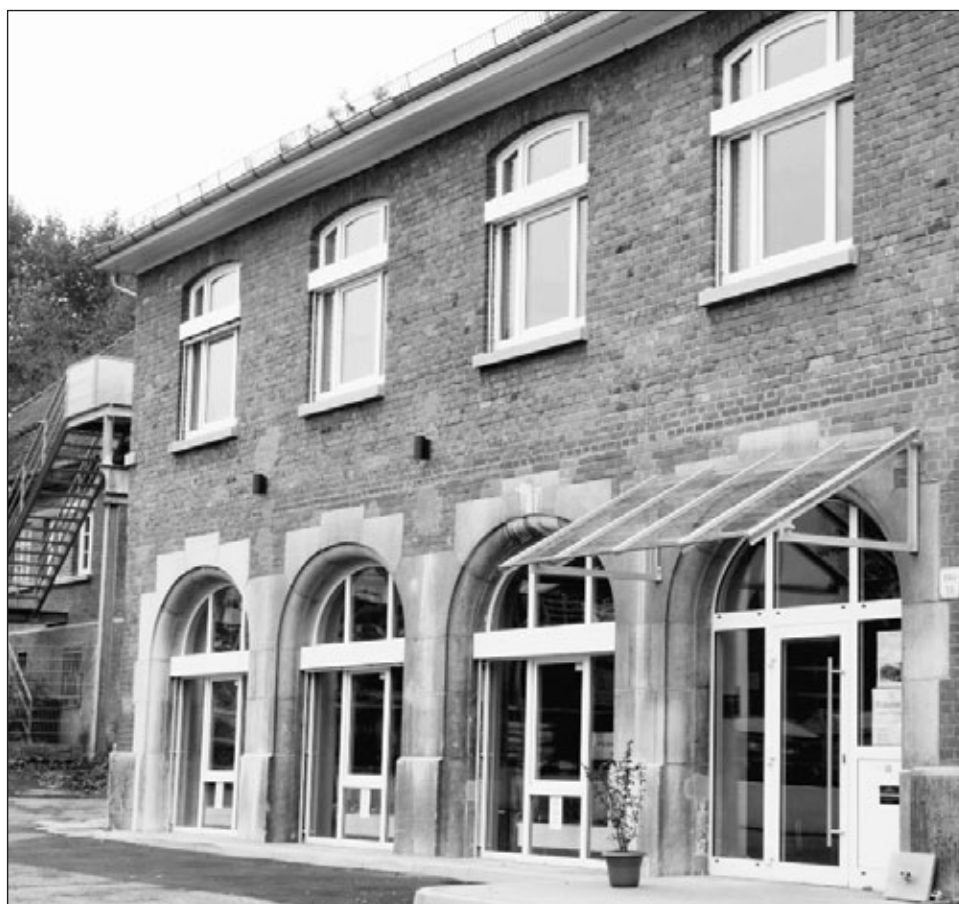
Frisch „herausgeputzt“ für aktuelle Aufgaben: die ehemalige Kantine der Firma Roller in der Schorndorfer Straße 56 beherbergt nun die Diakonie- und Sozialstation. Foto: Greiner
