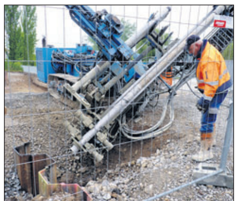
Mit der „Bohrmaschine“ geht's im 45-Grad-Winkel zwölf Meter tief ins Erdreich, wo die Spuntwände verankert werden.
