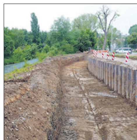
Die Fahrwinde für die Bohrmaschine, mit der die Spuntwände befestigt wurden; sie bildet nach einem nochmaligen Aushub von drei Metern, das Bett für das Gerinne. Fotos: Redmann
