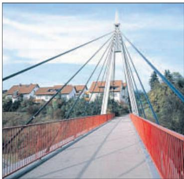
Die Schrägkabelbrücke mit Stahlpylon von Prof. Leonhardt verbindet den Waiblinger Galgenberg mit der Korber Höhe. Der 62 Meter breite Fußgängersteg, der im Stuttgarter Büro Leonhardt, André und Partner entwickelt worden war und der am 13. September 1988 seiner Bestimmung übergeben wurde, muss saniert werden. Foto: Archiv Öffentlichkeitsarbeit
