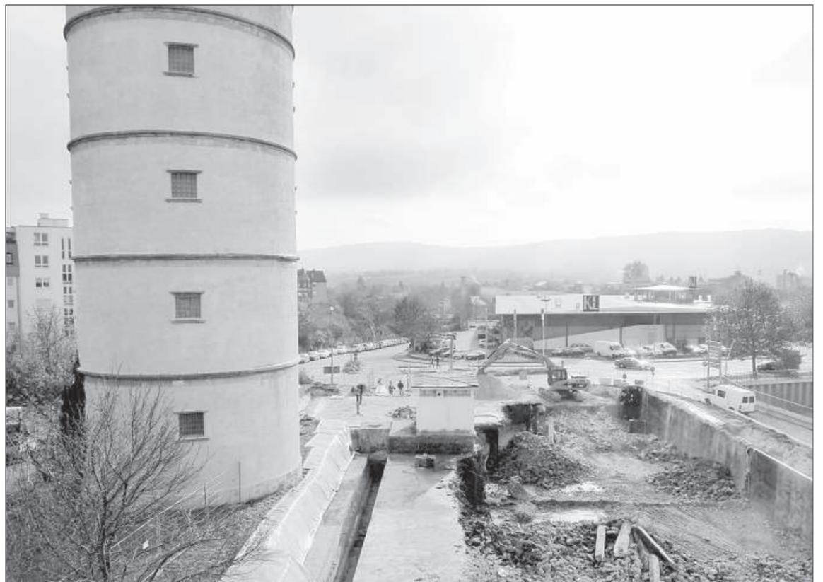
Wo jetzt eine tiefe Baugrube prangt und eifrig Bagger und Bauarbeiter ihre Arbeit verrichten, dort lagen noch vor wenigen Wochen zwei riesige Wasserspeicherbehälter aus dem Jahre 1952 unter der Erde verborgen. Am Ende der Baumaßnahmen im Frühjahr 2013 werden zwei neue Kammern unterirdisch für die Wasserversorgung von rund 10 000 Waiblinger Kunden sorgen. Fotos: Peters
