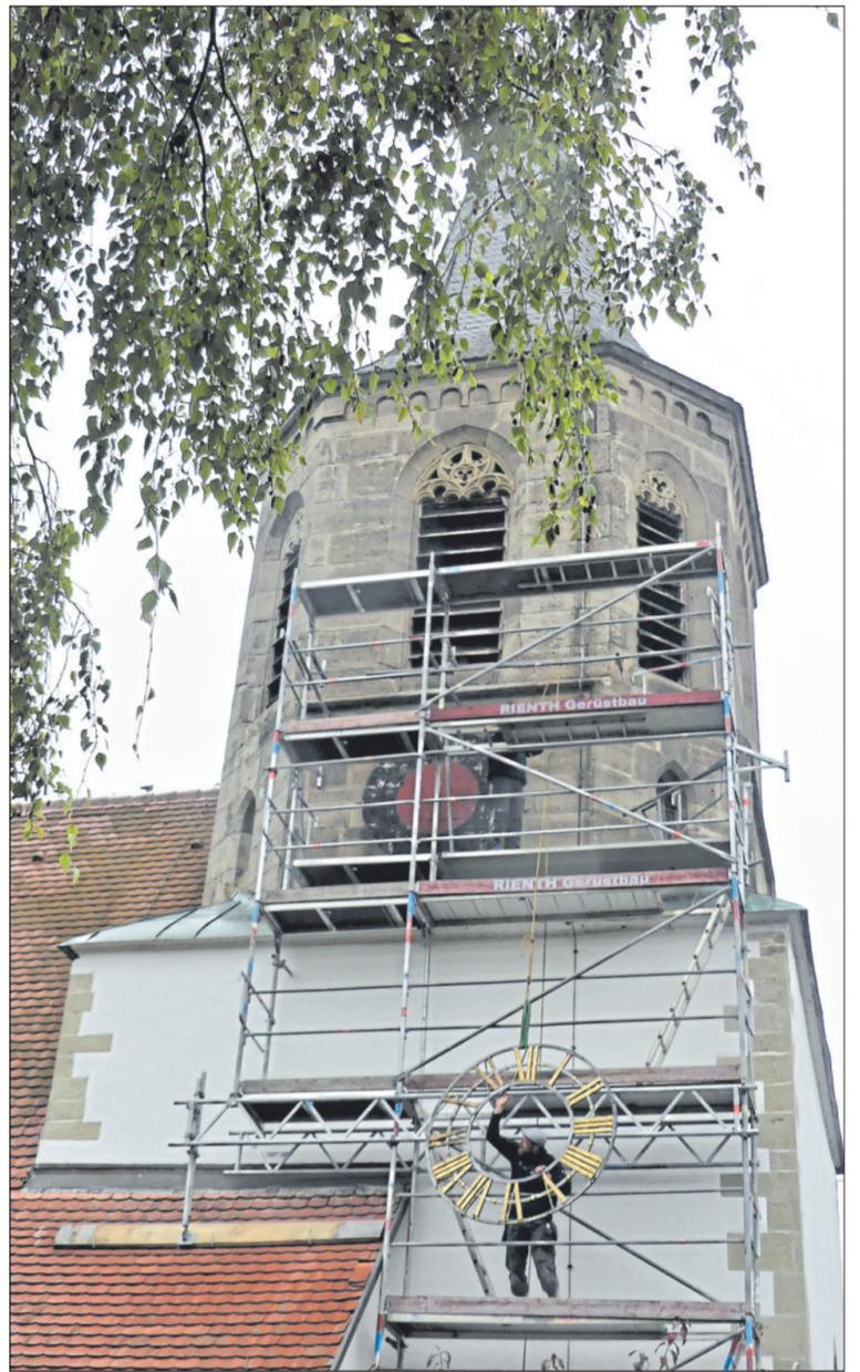
Auch wenn das Ziffernblatt gut gesichert ist, so ist es doch ein Kraftakt, das an die 90 Kilogramm schwere Metallobjekt schwebend und dennoch sicher gen Boden zu befördern, um es dann von Fachleuten sanieren lassen zu können. Falk Falkenberg von der Firma Eisenhart Turmuhrenbau aus Möglingen, „lenkt“ das Ziffernblatt umsichtig nach unten, während sein Kollege André Drondorf zwei Etagen höher am Gerüst die Leine sichert.
