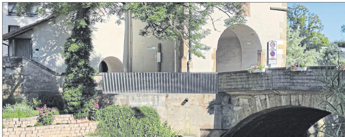
Im Foto schon realisiert: die Brüstung am Beinsteiner Torturm ist sanierungsbedürftig und wird durch ein Füllstab-Stahlgeländer ersetzt. Foto/Montage: Strauß
