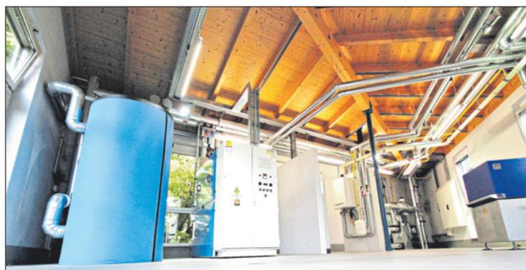
In der Heizzentrale der Stadtwerke Waiblingen in der Schorndorfer Straße 67 werden verschiedene Energieerzeugungsarten eingesetzt. Außer einem hohen Anteil an Kraft-Wärmekopplung wird unter anderem eine Wärmepumpe betrieben. Foto: Stadtwerke Waiblingen, Abteilung Wärme
