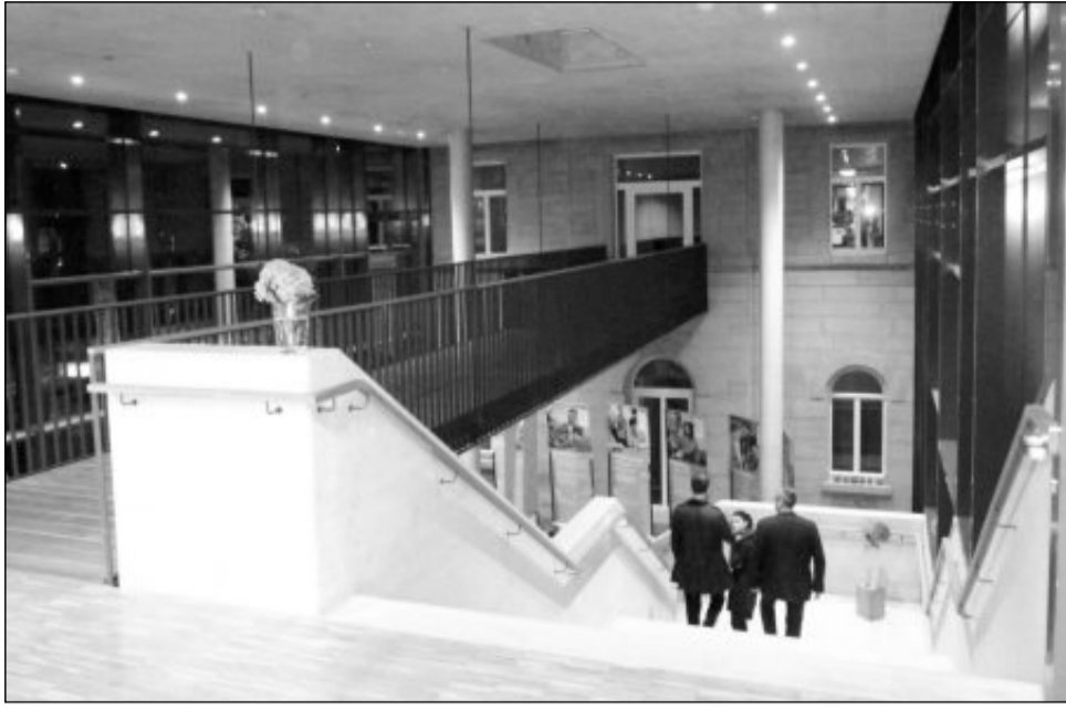
Ein gläsernes Treppenhaus verbindet den Neubau mit dem alten Bahnhof aus dem Jahr 1861.
