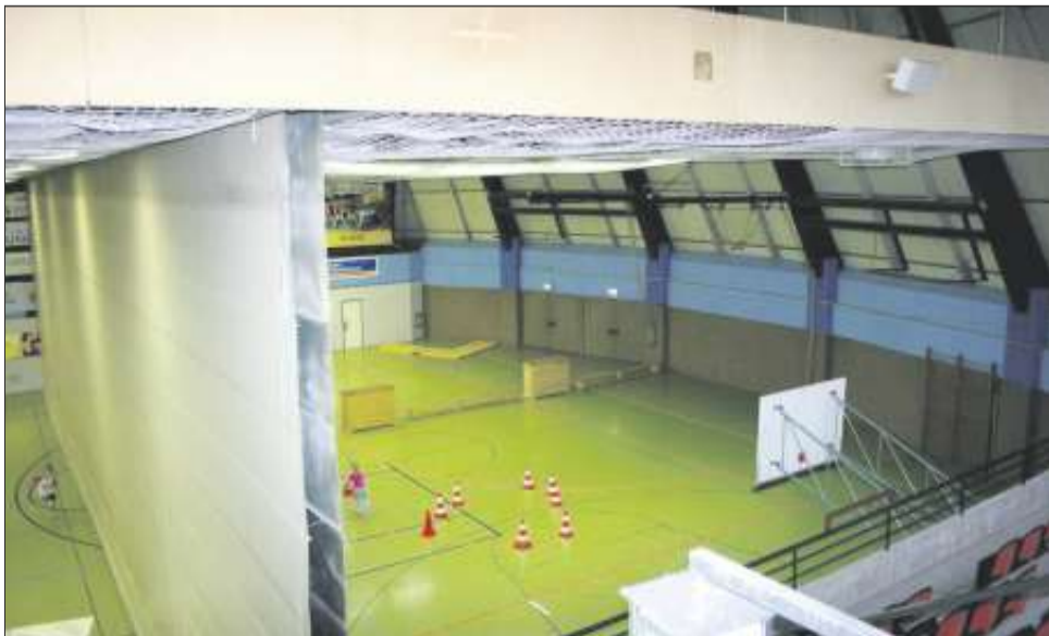
Die Kostengegenüberstellung für Neubau oder Sanierung der Rundsporthalle brachte ein eindeutiges Ergebnis. Diese sind für eine neue Halle am gleichen Standort fünf Millionen Euro höher. Unser Bild zeigt eine Aufnahme aus dem Jahr 2007. Foto: Archiv Abteilung Öffentlichkeitsarbeit
