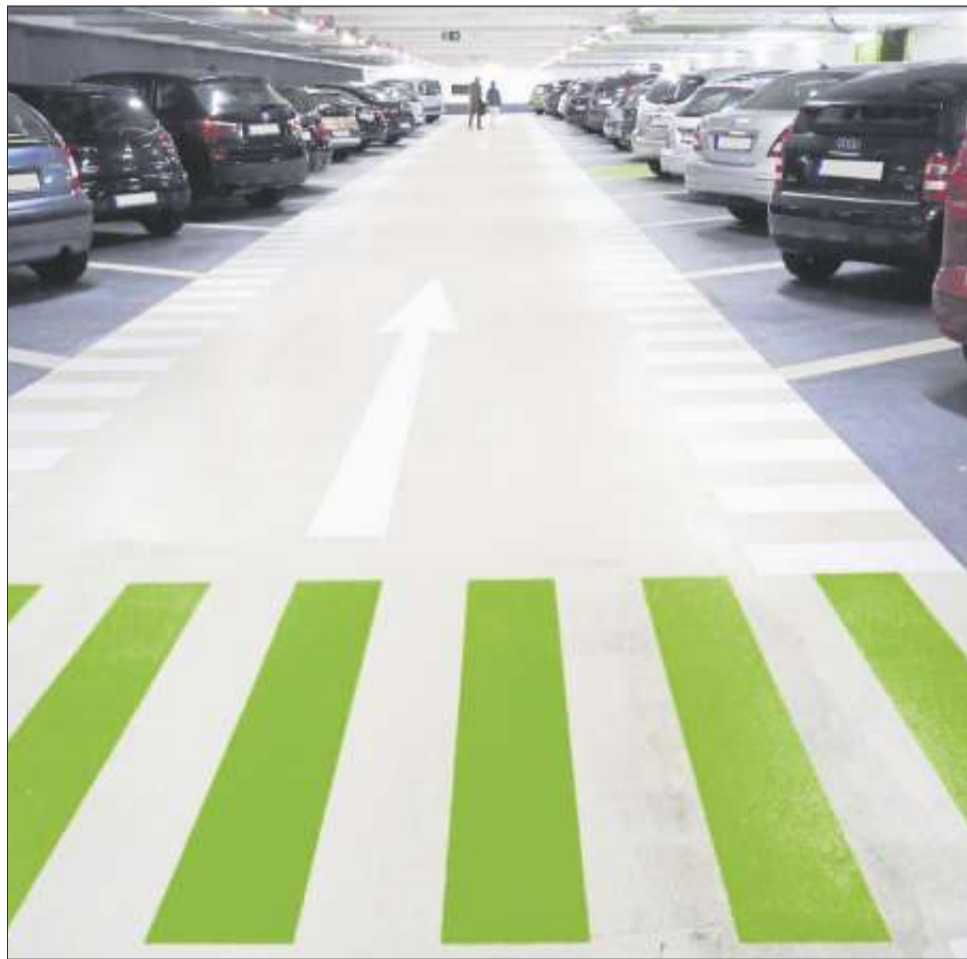
Die erste Ebene in der Marktgarage steht den Nutzern schon wieder zur Verfügung; in der zweiten wird derzeit gebaut. Anfang August ist Ebene drei an der Reihe. Foto: David
