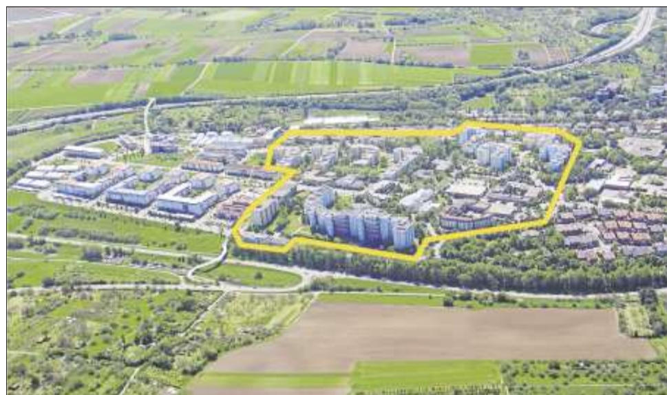
Vor allem die Umstellung von Nachtspeicheröfen auf Fernwärme soll in dem Gebiet Korber Höhe I den Kohlendioxidausstoß verringern und den Energieverbrauch senken. Foto: Stadtwerke
