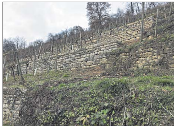
Blick auf den Weinberg Haufler in Neustadt – mit Sanierungsteilstück.
