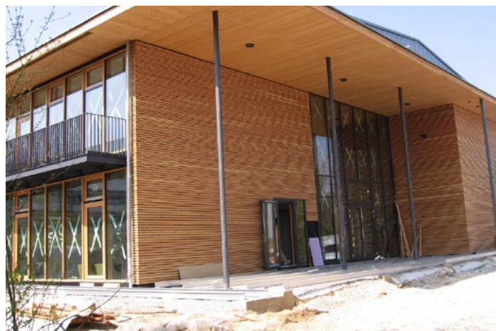
Karolinger-Grundschule im Bau
