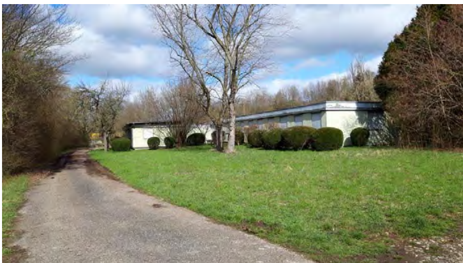
Abb. 3: Ansicht aus Südwesten auf das Gebäude im Untersuchungsgebiet
