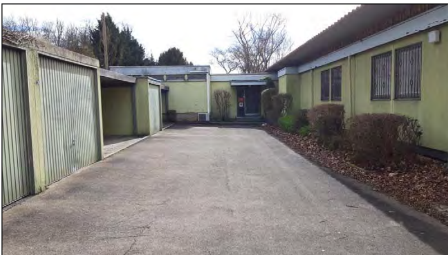
Abb. 8: Leerstehende Gebäude und Garagen
