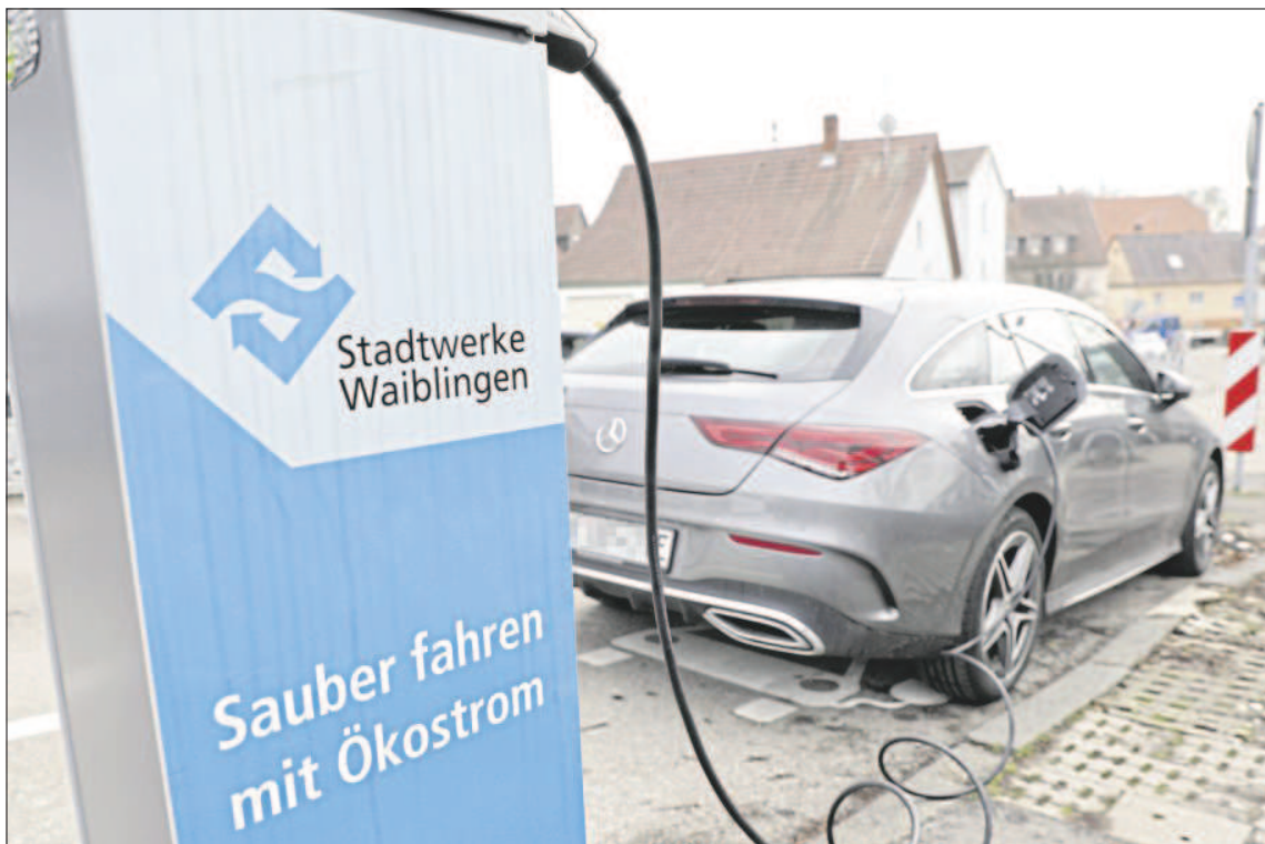
Die Elektroladesäule in der Schulstraße in Bittenfeld.
